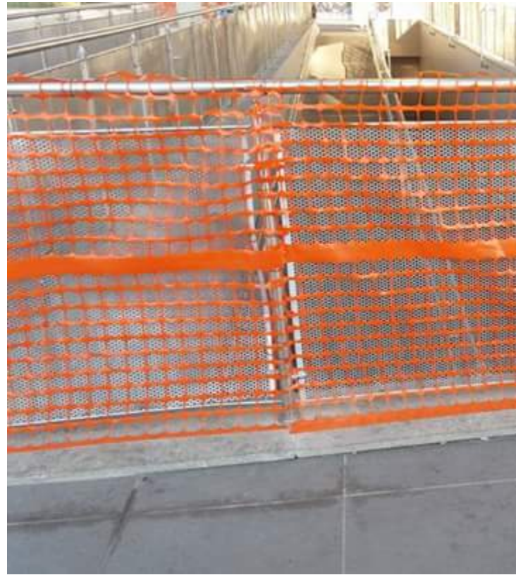
Lavori Stazione Ciampino
