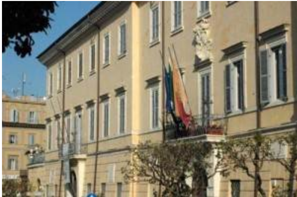
Facciata Palazzo Marconi a Frascati
