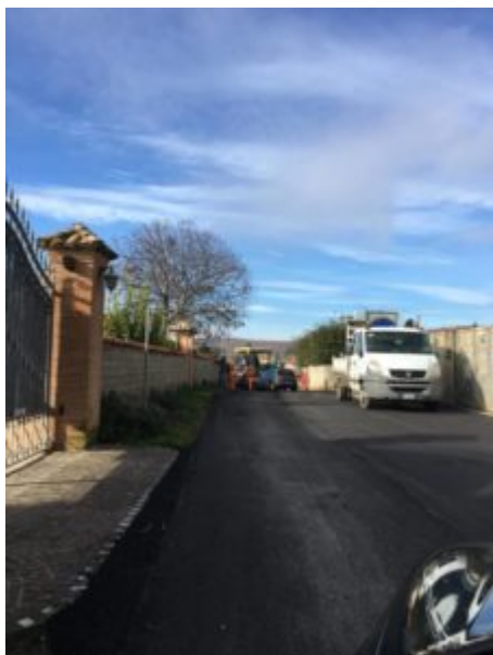
Lavori Colle Noce
