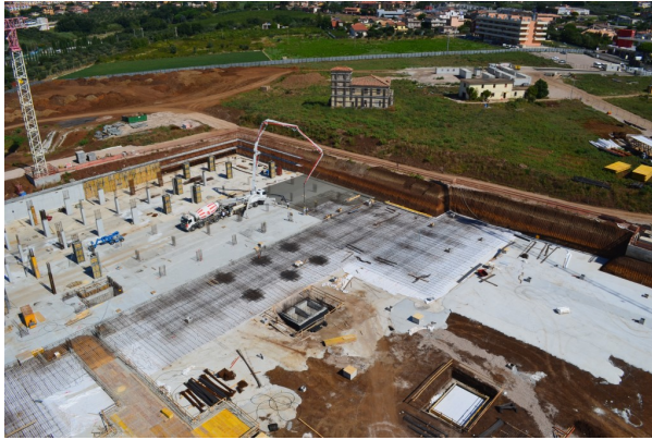
Cantiere lavori per Ospedale dei Castelli Romani
