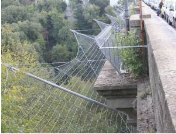
Ponte di Ariccia
