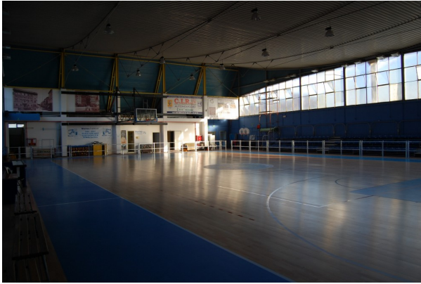
Palazzetto dello Sport di Cava dei Selci a Marino
