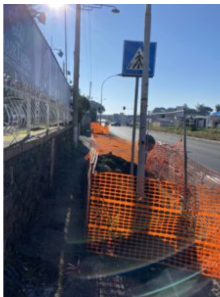
Lavori sull'aggiornamento dell'illuminazione pubblica di Via Nettunense”
