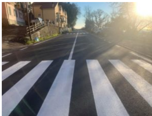
Rifacimento della segnaletica orizzontale di via Nemorense
