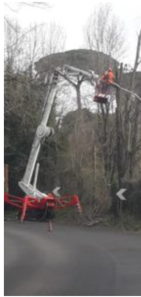
Lavori per la sicurezza stradale di Nemi
