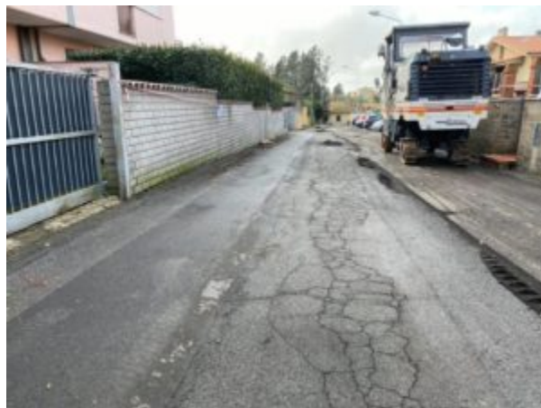
Lavori a Fontana Sala di Marino
