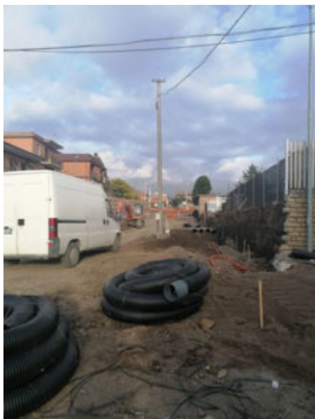
Lavori al sottopasso di Pavona
