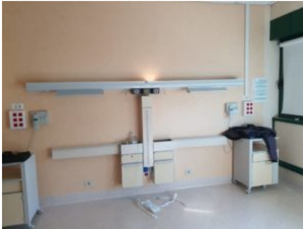
Lavori a Tor Vergata per nuovo Covid Hospital
