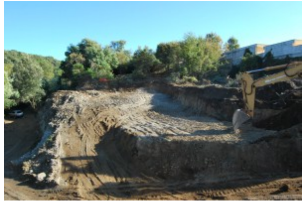
Cantiere parcheggio ad Ariccia
