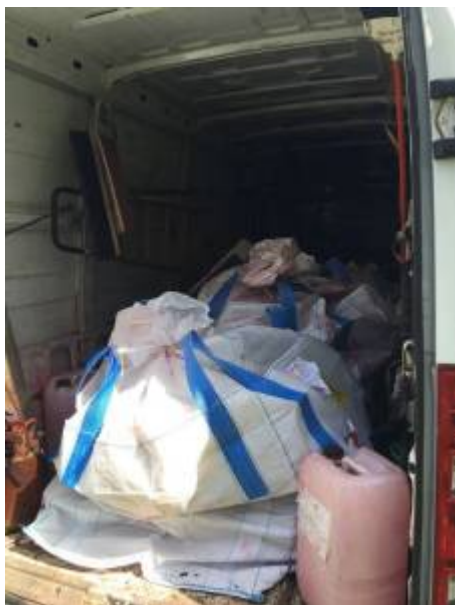
Rimosso Amianto a Rocca Priora
